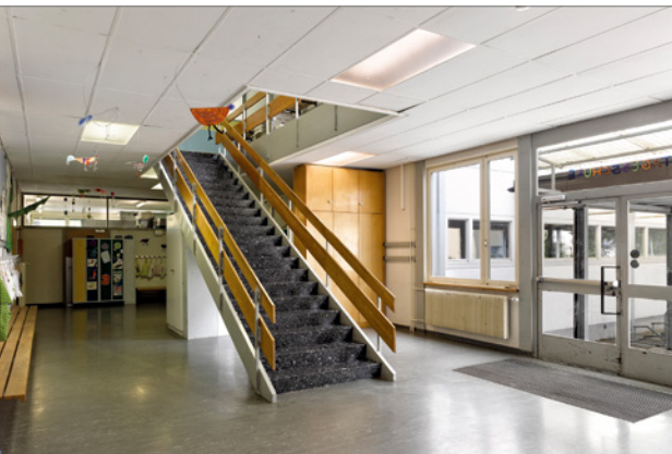
Das Schulgebäude am Winterfeldweg 15 wurde vor rund 50 Jahren erstellt. Es wurde noch nie saniert und weist mittlerweile erhebliche bauliche und betriebliche Mängel auf (im Bild ist der Eingangsbereich zu sehen).
